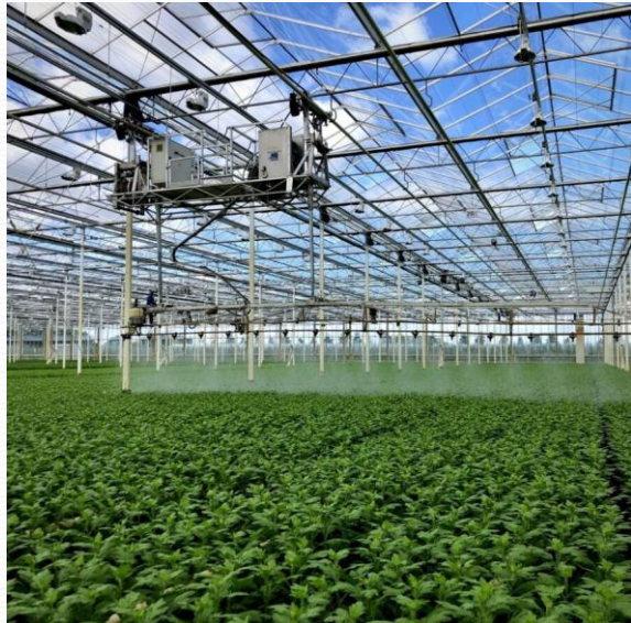
Tưới hoa cúc bằng hệ thống phun sương
