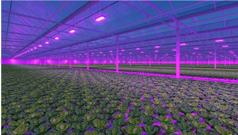
Hình. 1.3.9. Hệ thống đèn led chiếu sáng của nhà màng
