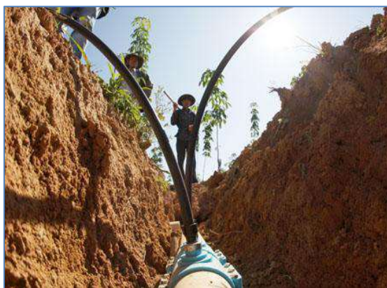
Hình 1.4.8. Lắp đặt hệ thống đường ống chính
