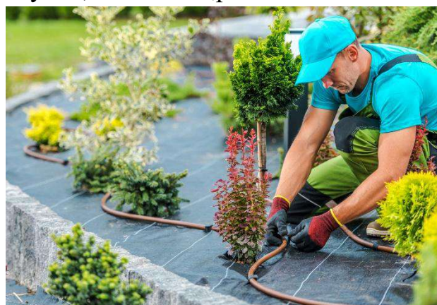
Hình 1.4.10. Kiểm tra hệ thống tưới
