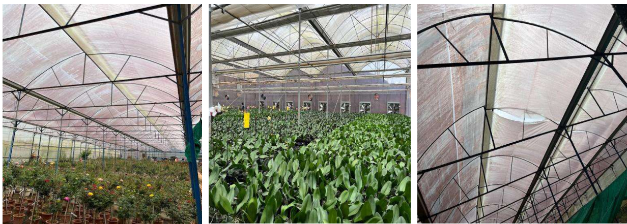
Hình 1.6.39. Mái nhà màng cần vệ sinh, kiểm tra sửa chữa
