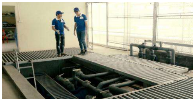
Hình 1.3.20. Kiểm tra định kỳ hệ thống cấp nước và thoát nước nhà màng
