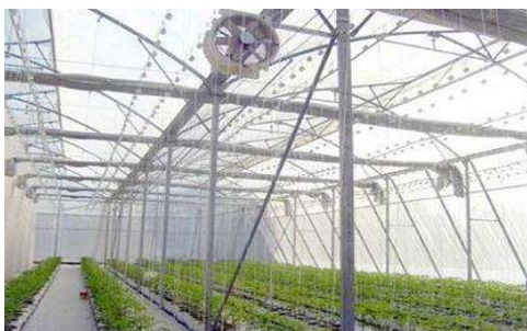
Hình 1.5.3. Lắp đặt các quạt thông gió
