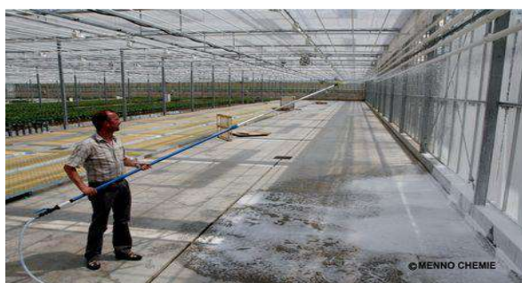
Hình 1.6.44. Dùng máy phun nước áp lực cao vệ sinh vách nhà màng
