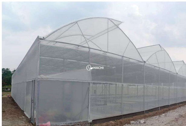
Hình 1.3.12. Hệ thống lưới bao quanh nhà màng
