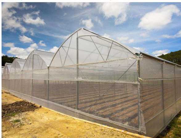
Hình 1.3.7. Nhà màng cần được che kín bằng các loại màng che hoặc lưới
