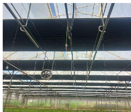
Hình 2.4.16. Hệ thống làm mát nhà màng
