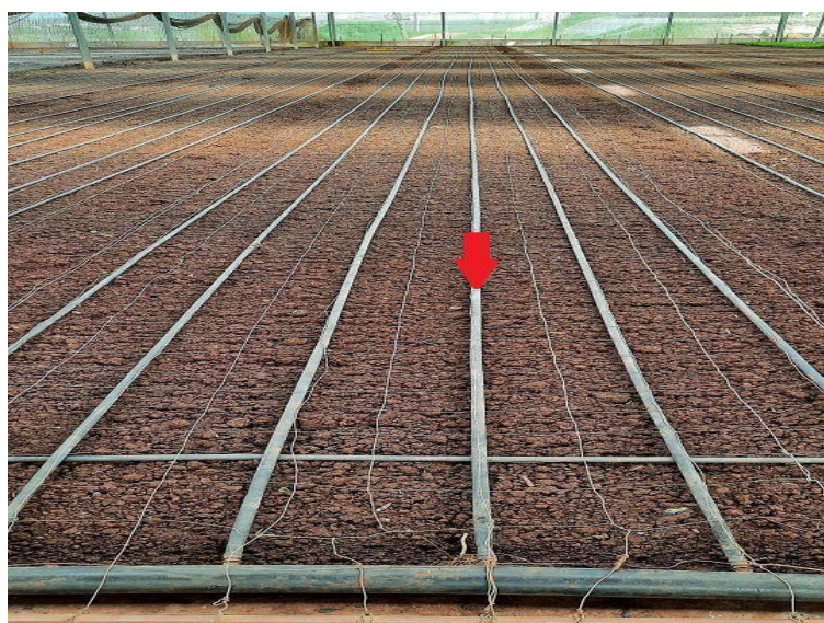
Hình 3.2.8. Lắp hệ thống tưới
