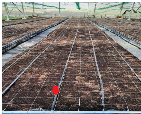
Hình 3.2.23. Lắp hệ thống tưới
