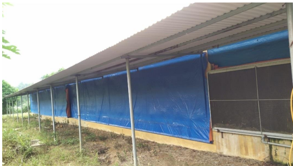
Hình 54. Làm mái che dàn mát và bạt che nắng
