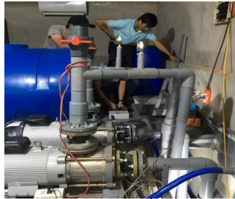
Hình 2.11. Lắp đặt thiết bị điều khiển tự động tích hợp với hệ thống máy tính cho hệ thống quạt hút tản nhiệt và hệ thống bơm tưới
