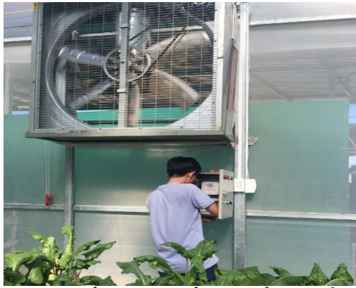
Hình 2.11. Lắp đặt thiết bị điều khiển tự động tích hợp với hệ thống máy tính cho hệ thống quạt hút tản nhiệt và hệ thống bơm tưới
